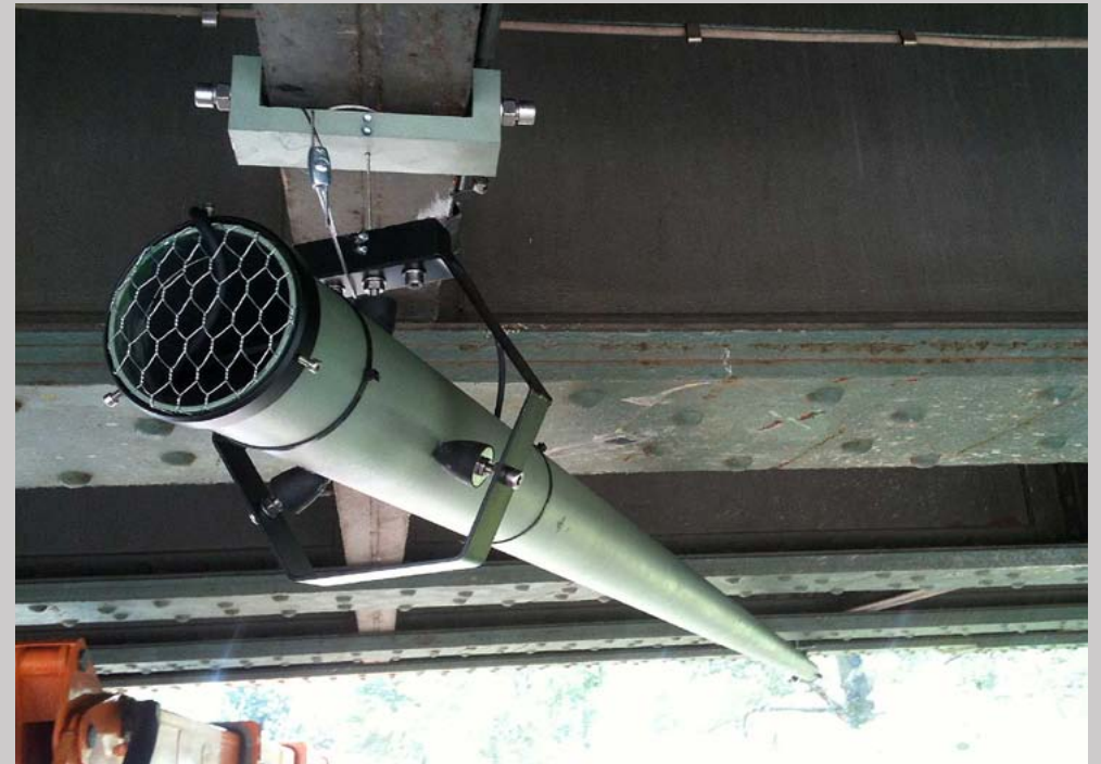
B tube Deutschherrnbrücke south
